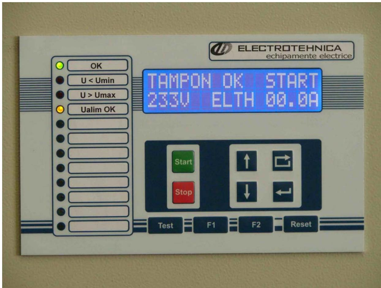
Aceasta serie moderna de redresoare este conceputa cu un sistem digital integrat de control, monitorizare si semnalizare cu multiple functii standard sau la cerere (optionale), realizat cu microprocesor de semnal (DSP-Texas Instruments).
